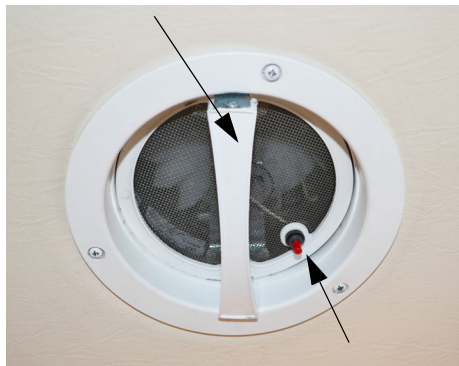
Fan Power Switch
